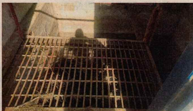
Tanque de desarenado sin mantenimiento
