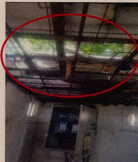
Láminas de eternit en mal estado
