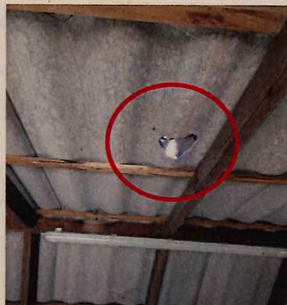
Láminas de eternit fisuradas
