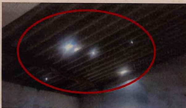
Láminas de eternit fisuradas
