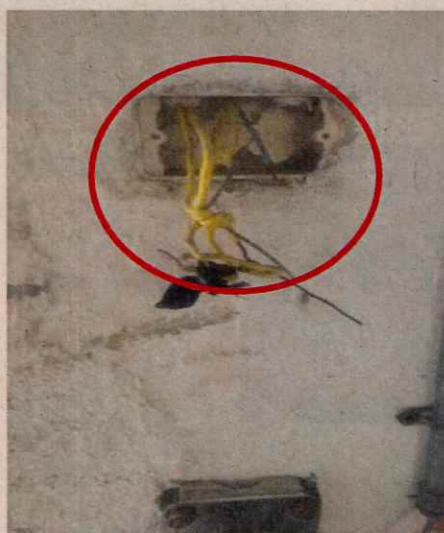
Interruptores eléctricos en mal estado
