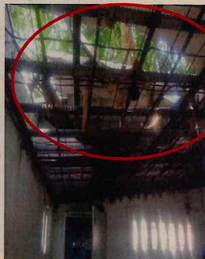
Láminas de eternit en mal estado
