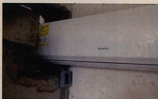
Sistema de Aire acondicionado en mal estado y no es el adecuado para el cuarto eléctrico
