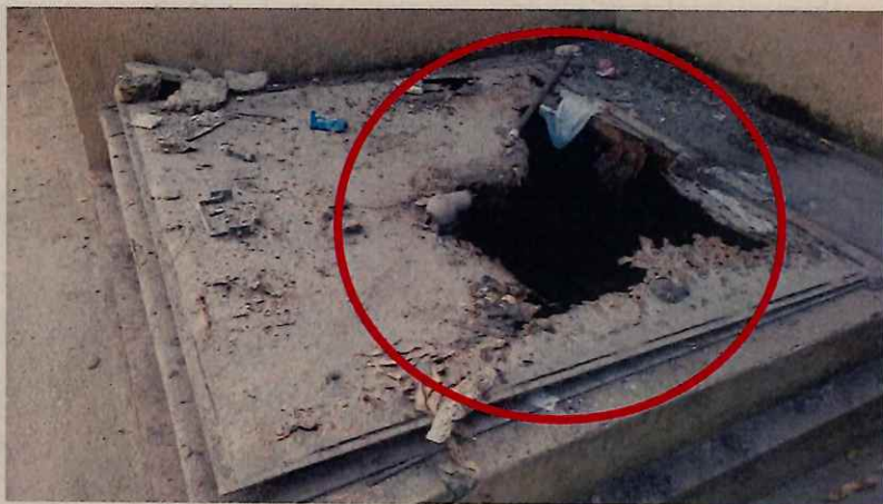
Tapa del desagüe de la línea de salida en mal estado
