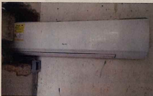
Sistema de Aire acondicionado en mal estado y no es el adecuado para el cuarto eléctrico
