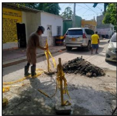
ILUSTRACIÓN INSTALACIÓN DE TAPA DE MANHOLE.
