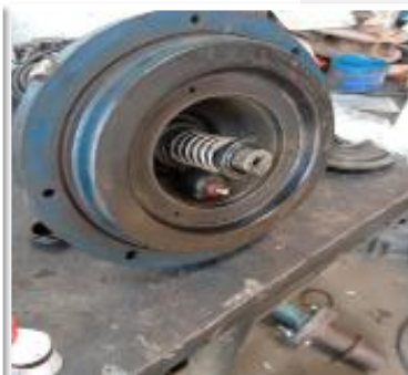
EBAR Rodadero Reservado: Mantenimiento al motor de arranque. EBAR Fénix: Reparación de bomba, se cambiaron los sellos mecánicos, se aplicó barniz dieléctrico, se cambió el aceite.
