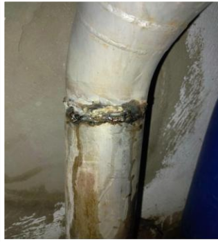
Pozo 6: Trabajo de soldadura por fuga.
