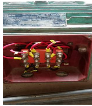
EBAP Santa Helena: Se deja instalada la segunda bomba.
