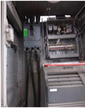
Mantenimiento realizado en EBAR Norte
