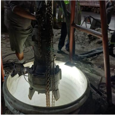
EBAR Norte: Instalación de bomba de achique.
