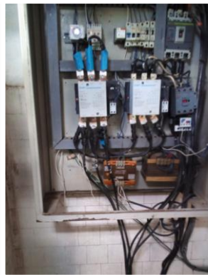
Mantenimiento realizado en EBAP Bastidas
