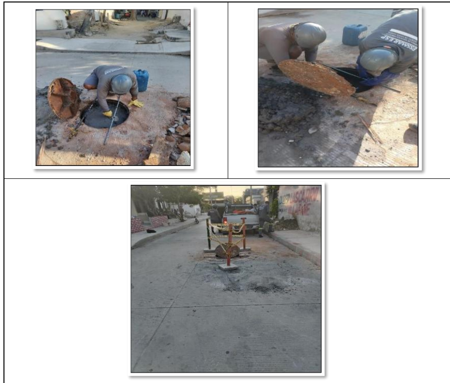
Registro fotográfico instalación de tapa de manhole, Gaira.
