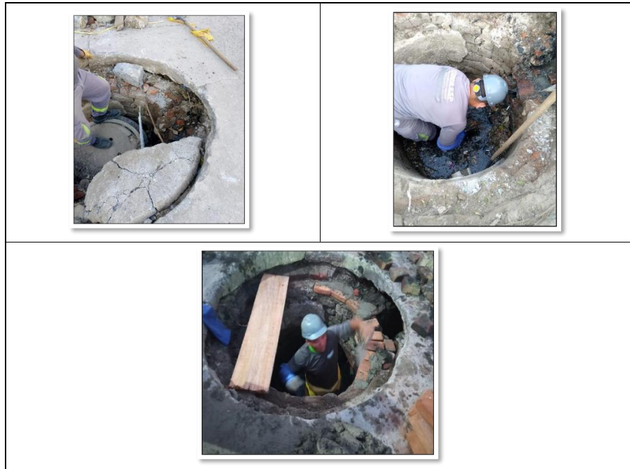
REGISTRO FOTOGRÁFICO INSTALACIÓN DE TAPA DE MANHOLE, JARDIN.
