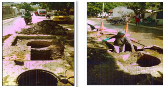
REPARACION E INSTALACION TAPA DE MANHOLE 17 DE DICIEMBRE.
