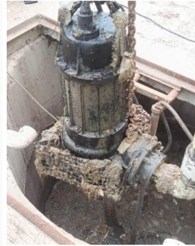
Mantenimiento realizado en la EBAR Salguero
