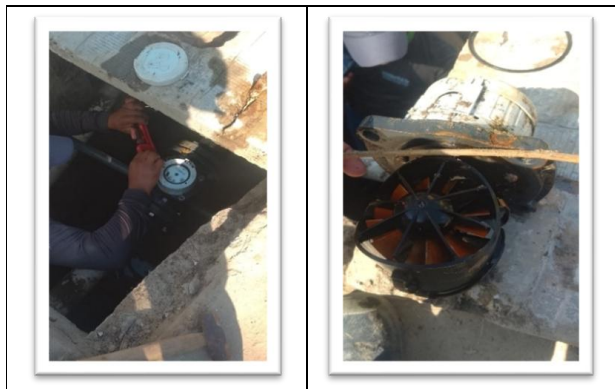
Clínica del Prado – SOMESA, medidor no visible
