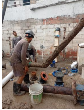
Mantenimiento realizado en POZO 8
