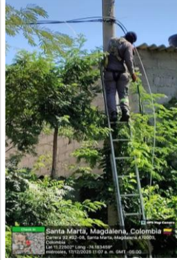
Pozo U2: Se adecuó acometida trenzada en el pozo U2 y U3
