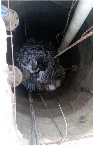
EBAR Sierra Laguna: Se realiza limpieza de sensores.
