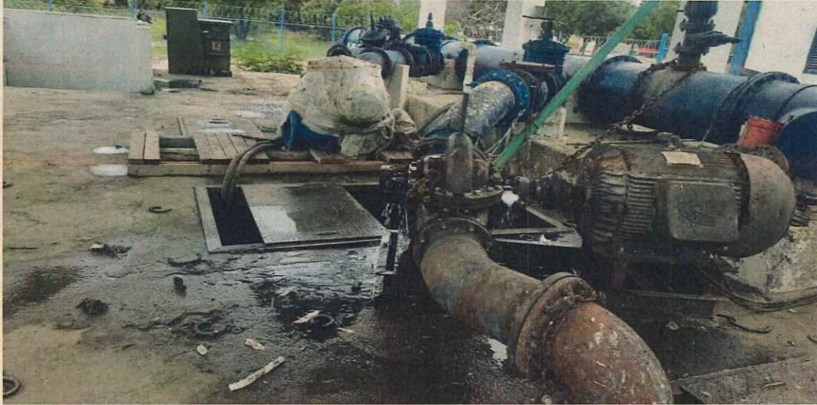
Fuga en carcazas de bomba de superficie
