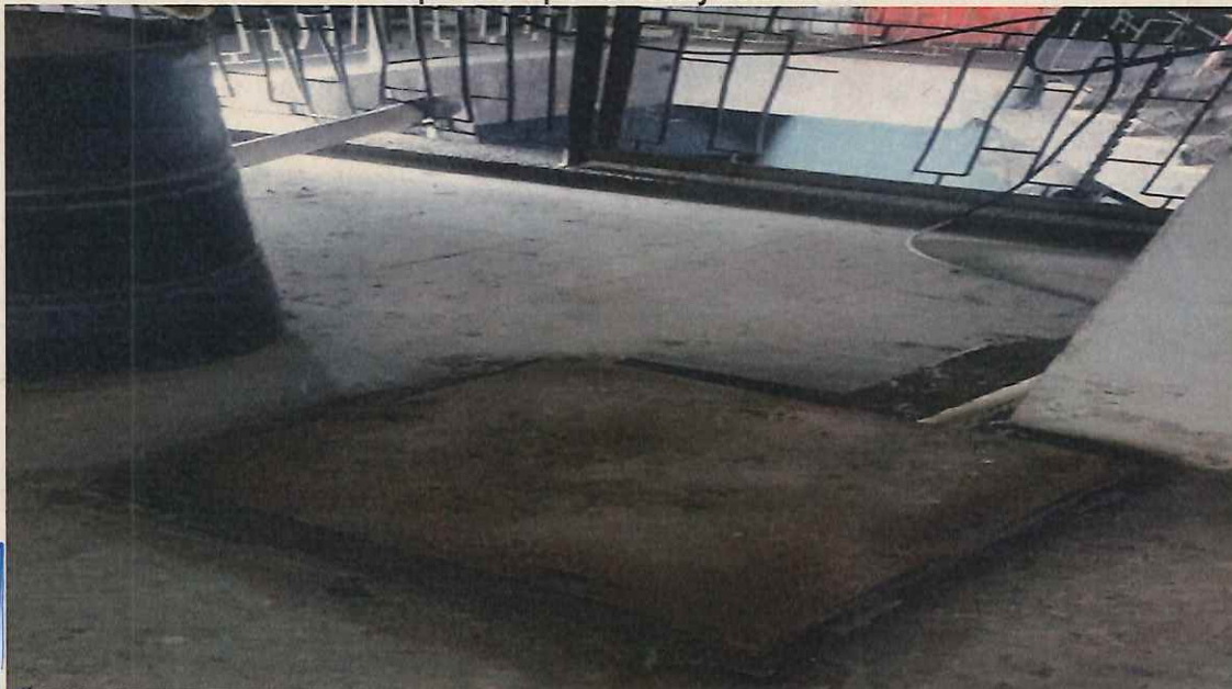
Tapa de tanque húmedo y deteriorado
