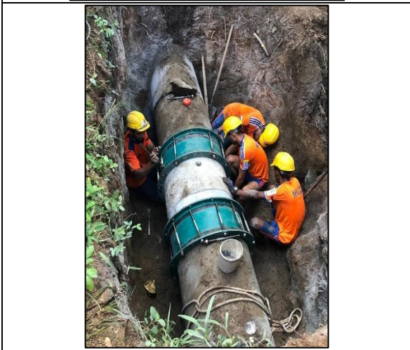
Foto 5 – 12. Reposición de tramo de tubería de 24” AC por fuga en unión
