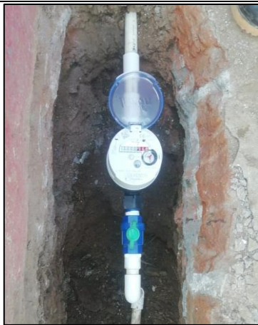
Foto 7 y 8. Instalación de micromedidor de 1/2"
