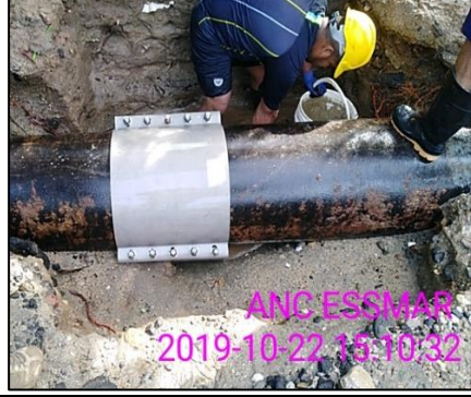
Foto 1 – 4. Instalación de accesorio para reparación de fuga 20”
