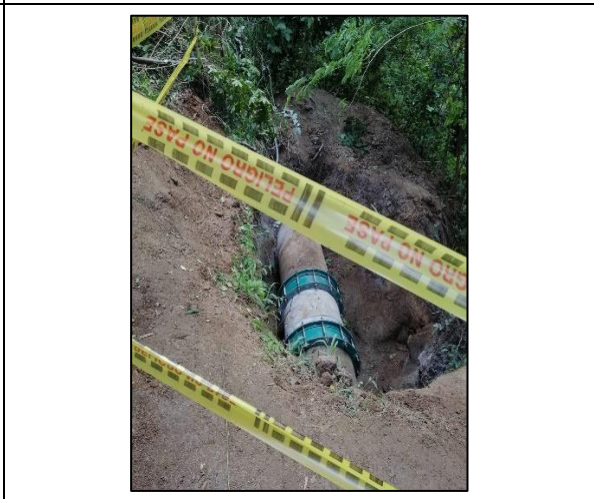
Foto 5 – 12. Reposición de tramo de tubería de 24” AC por fuga en unión
