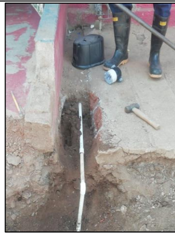
Foto 7 y 8. Instalación de micromedidor de 1/2"
