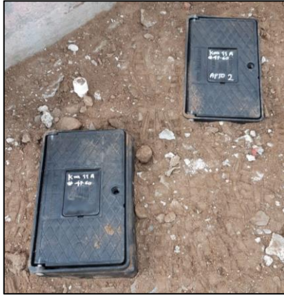
Foto 5 y 6. Instalación de micromedidores
