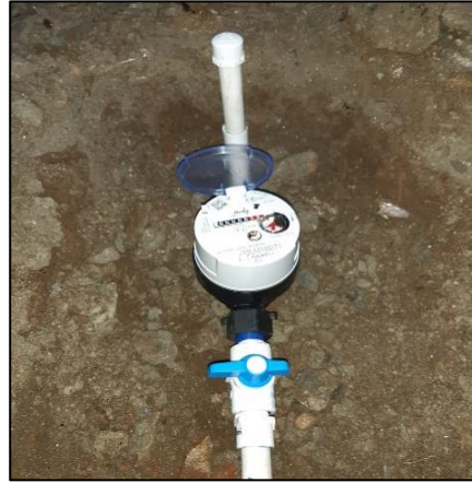
Foto 5 y 6. Instalación de micromedidores
