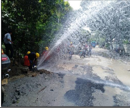
Foto 1 – 4. Instalación de accesorio para reparación de fuga 20”
