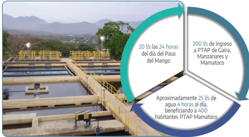
Ilustración 4. Recuperación de caudales PTAP Mamatoco
