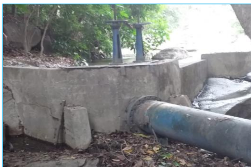
Ilustración 12. Captación 2 Río Gaira.
