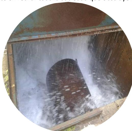
Ilustración | Estructura Rompepresión.
