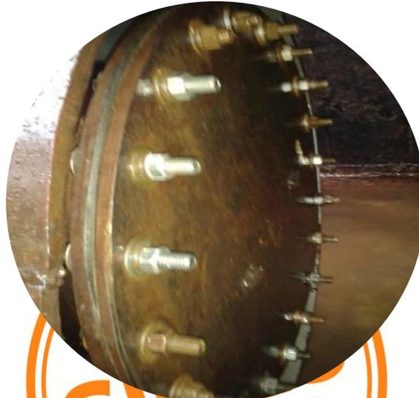
*Ilustración 4 Tapa del Rompepresión Ajustada*
