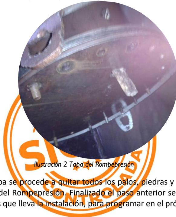
Después de retirada la tapa se procede a quitar todos los palos, piedras y hojas que se encuentra obstruyendo los orificios del Rompepresión. Finalizado el paso anterior se verifica el estado de la Camisa y el de los tornillos que lleva la instalación, para programar en el próximo mantenimiento el cambio de estos.
