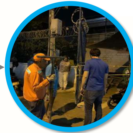
Mantenimiento o de pozos
